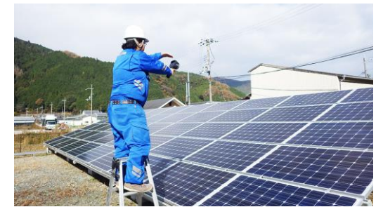
ハンディの赤外線カメラ点検の様子。 一つずつ地道に点検を行うため、かなり手間がかかる。
